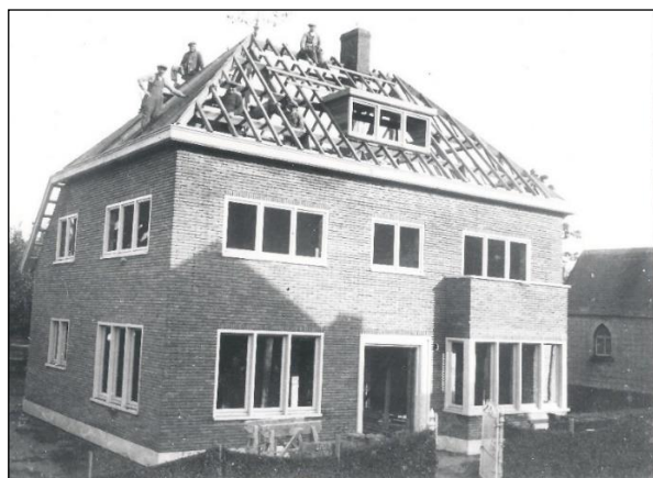
De bouw van de nieuwe woning van hoofdonderwijzer op rust Pieter Mestdach.
